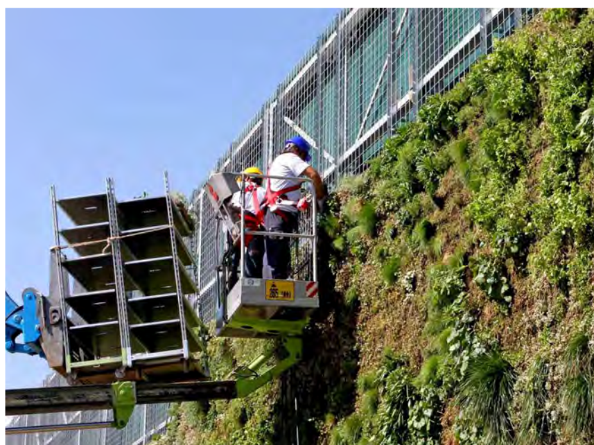
Settembre 2010 Posa Green Box /September 2010 Installation of the Green Box
