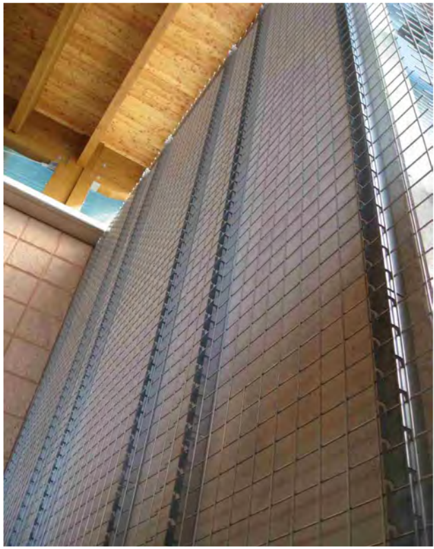
Rete posata su muro portante
